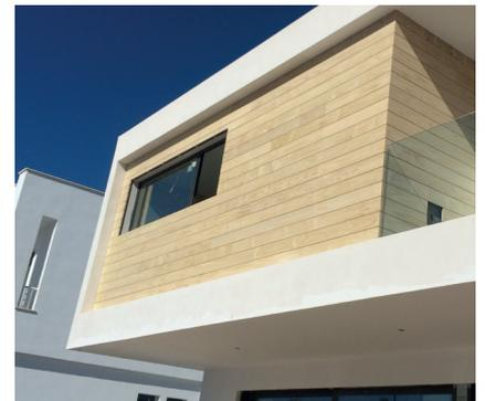
La utilización de un rastrel de madera tropical, grapa y tornillo de acero inoxidable, adhesivos correspondientes, una tarima con un secado correcto y buena mecanización y un sencillo mantenimiento, bastarán para tener un buen entarimado de exterior.
